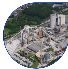
Fourniture d'O 2 + captage de CO 2
